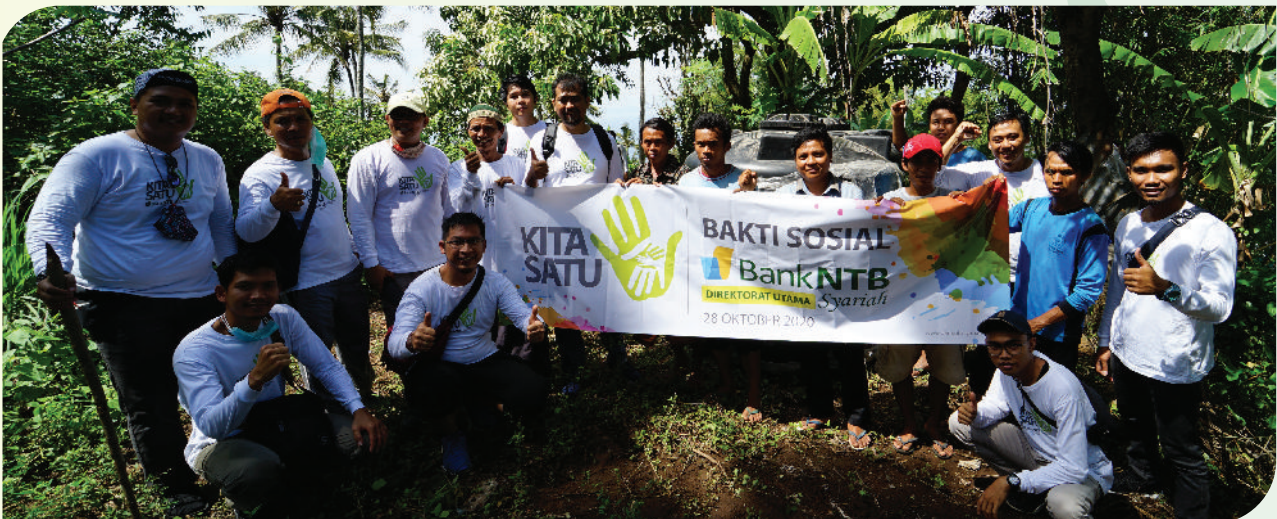
"Team Bakti Sosial dari Direktorat Utama dengan semangat memberikan bantuan pemasangan pipa air dan tandon di Gunung Mas" "The Social Service Team from the Main Directorate is enthusiastic about providing assistance in installing water pipes and reservoirs in Gunung Mas"
